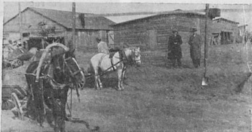
Сооружение бараков для рабочих московской автосборочной (середина октября)
